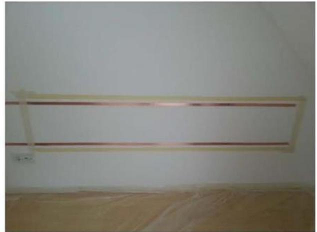
Le système de chauffage Carbon4 se compose de : ruban adhésif spécial appliqué sur les surfaces, bandes de cuivre, trame tissée, peinture chauffante, raccordement électrique, unité de commande, thermostat numérique, capteurs en cas d'application au sol et transformateurs de courant.
